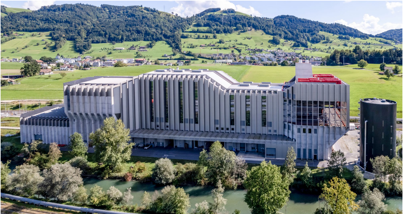
Renergia Zentralschweiz AG valorise environ 280 000 tonnes de déchets par an et produit de la vapeur industrielle, de la chaleur à distance à partir de la chaleur dégagée par l'incinération des déchets et également de l'électricité.
